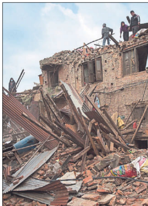
Die Habseligkeiten der Menschen sind unter Trümmern verschüttet.
